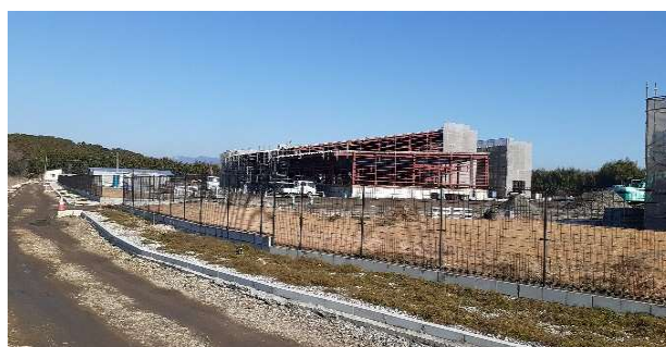
建設中の新工場（R4.12月時点）
