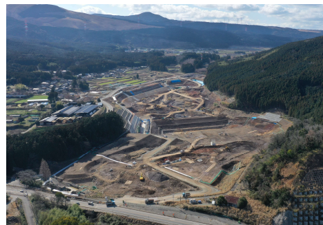
大切畑ダムの復旧状況（R5.2月）
